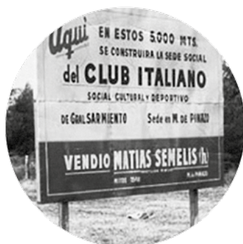
Figura 16. Imagen del cartel de obra.
