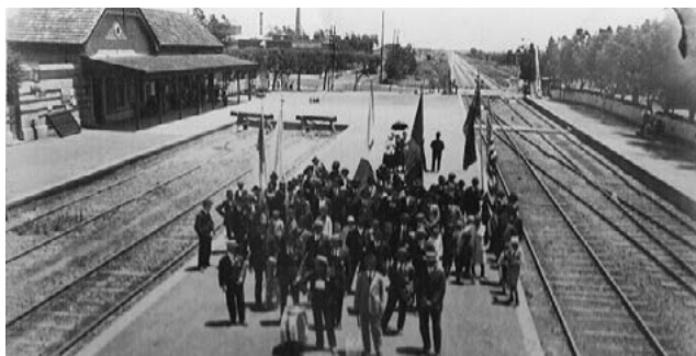
Figura 3. Inauguración de la Estación “Arroyo Pinazo”, 8 de octubre de 1906.
